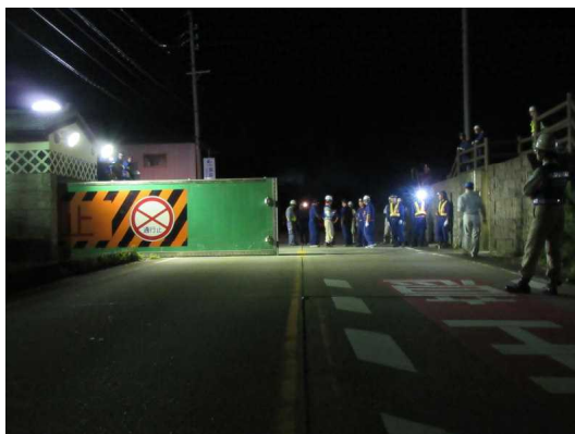
陸閘閉鎖作業状況
