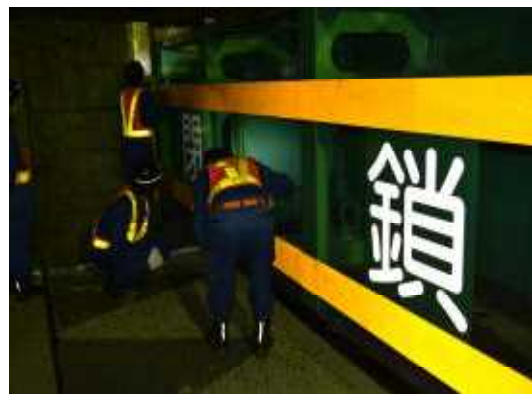
陸閘点検実施状況
